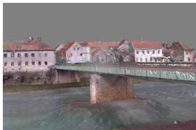
Ispitivanje infrastrukture u gradu Karlovcu: lijevo - batimetrijsko ispitivanje korita rijeke Kupe; desno - razvijeni 3D model Banijskog mosta na temelju oblaka točaka
